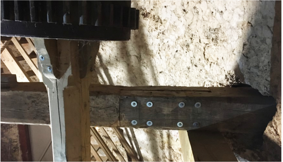
Deckenbalken austauschen und anblatten.
