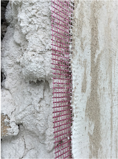
Außenputz: Gewebe mit Muschalkalk in 3 Lagen.
