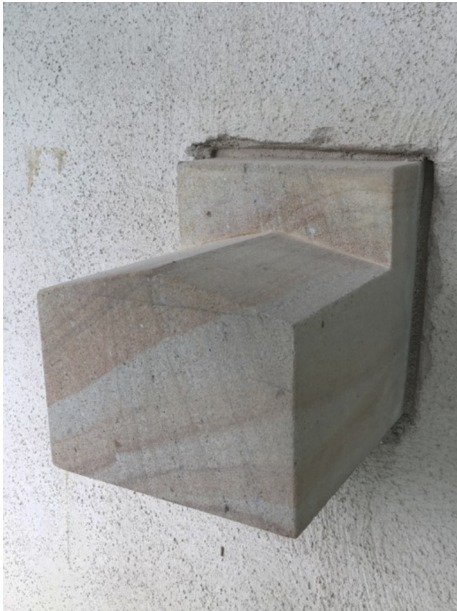
Einbau Sandsteinstützen für Galerie (Mai 2018) Einbau Sandsteinstützen für Galerie (Mai 2018).
