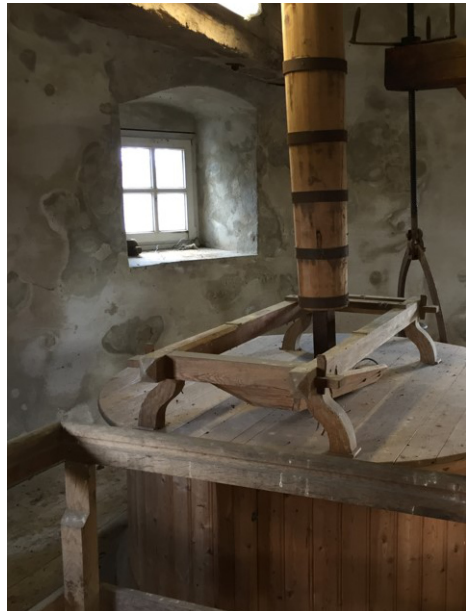
Putz- und Wasserschäden innen vor der Sanierung.
