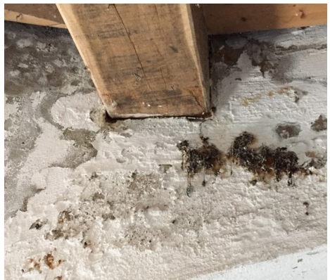
Putz- und Säureschäden Erdgeschoss innen.
