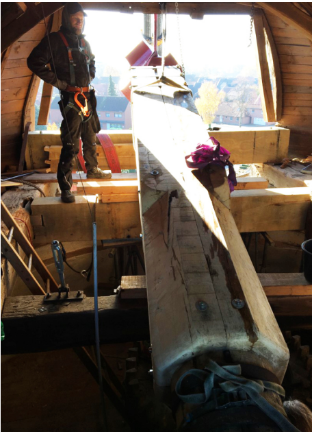
Flügelwelle jonglieren in der Dachkuppe.
