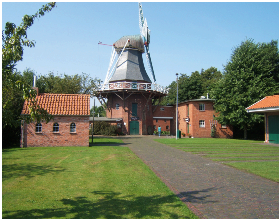
Die Mühle Leezdorf mit Anbauten.
