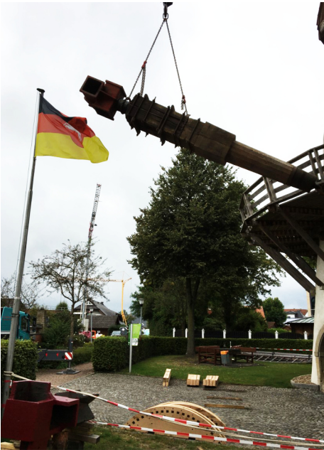
Einbau neue Flügelwelle.
