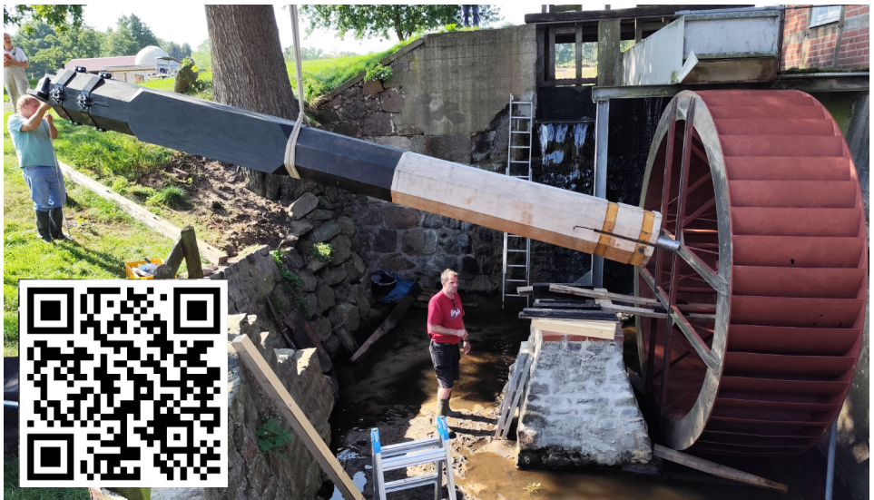
Einbau Wasserwelle.
