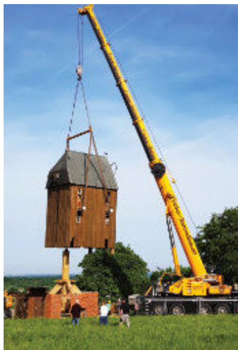
Ein Schwerlastkran hebt am 19. Mai 2022 den Mühlenkasten auf den erneuerten Hausbaum.
