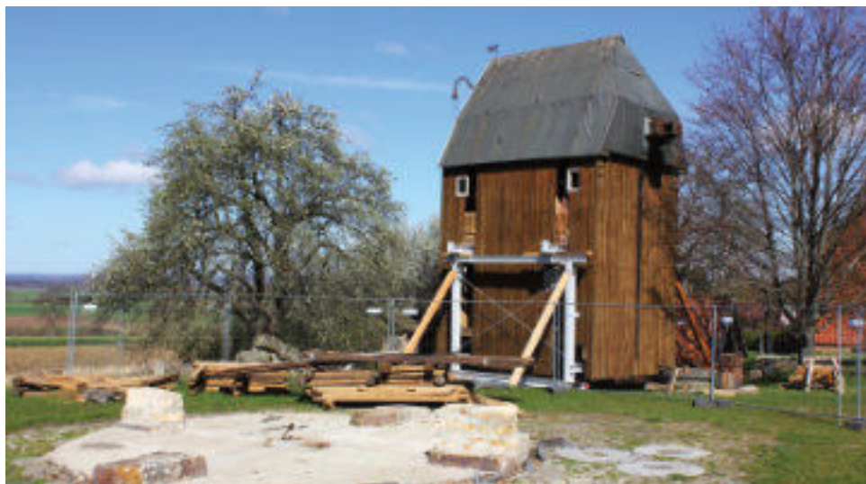
April 2022: Der Mühlenkasten hängt in einem Stahlgerüst, im Vordergrund die Fundamente der Bockwindmühle. Der hölzerne Bock ist vollständig demontiert und in die Werkstatt des Mühlenbauers gebracht worden.
