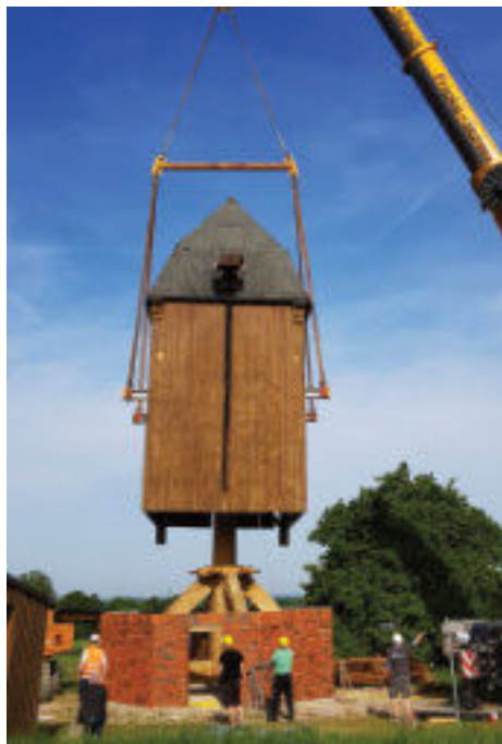
Langsam wird der Mühlenkasten abgesenkt und der Hausbaum passgenau eingefädelt.
