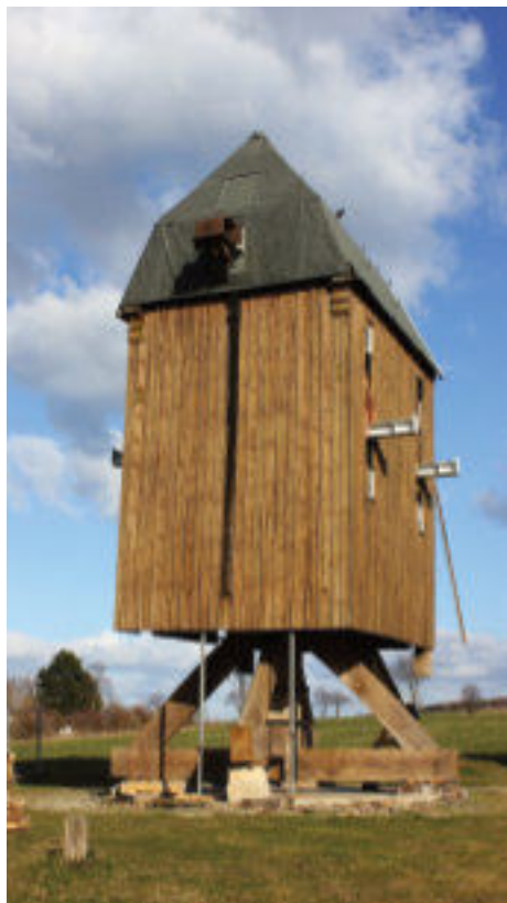
März 2022: Die Bockwindmühle ist zum Abbau vorbereitet. Die Umhausung des Bockes wurde entfernt und zwei Traversen aus Stahl durch den abgestützten Mühlenkasten gezogen.
