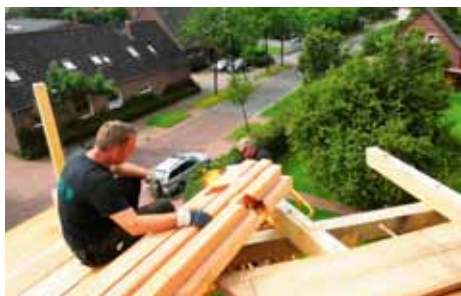
Henno Böök und Diedrich Schlachter 2016 bei der Montage der Planken der neuen Galerie. Die Kunststoffleisten sind auf den Liggern bereits vormontiert.
