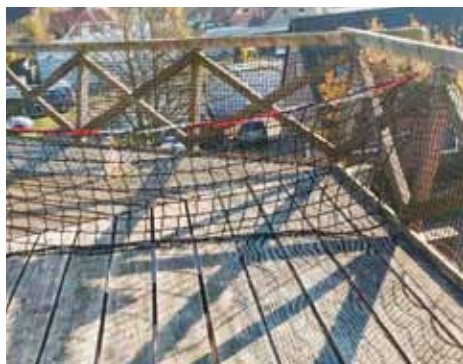
Netze dienen zur Sicherung des Geländers und als Durchgangssperre.
