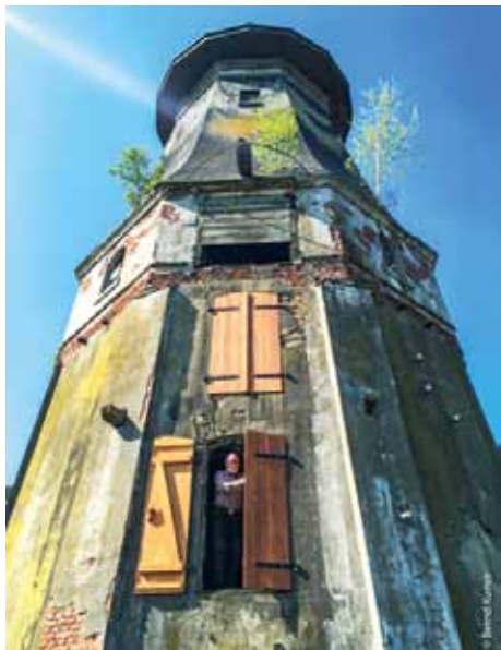
Der Torso der Windmühle Stühr in Martfeld mit neuen Türen im 1. Stock. Fotos: Klerings
