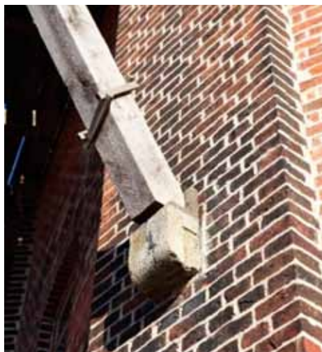
Auflage der großen Schoren mit Robinienbrettern und Tropfleisten.
