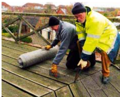
Auf die Planken wird ein Drahtgeflecht als Rutschschutz getackert. Fotos: E. de Buhr
