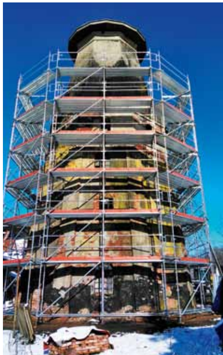
Die eingerüstete Stührmühle in Martfeld im März 2023. Foto: G. Scheweling
